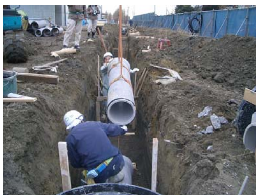
写真-3 敷設状況
